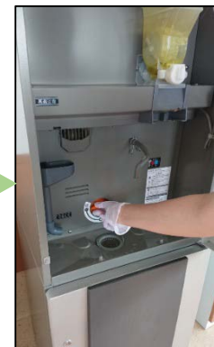
⑦排水コックを「開」にし 排水後「閉」に戻す
