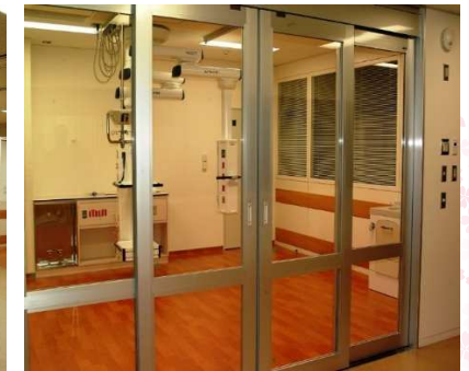
3F ICU個室
