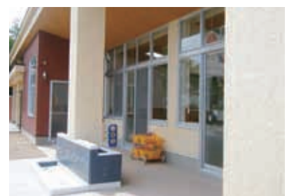
テラス(雨天時にも利用できる半屋内スペース)
