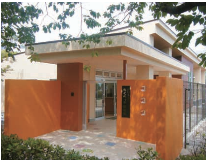
保育園入口から全景(モニター付インターホン及び電気錠にてセキュリティを確保)
