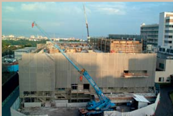
新中央診療棟現場の進捗状況(平成20年11月7日)
