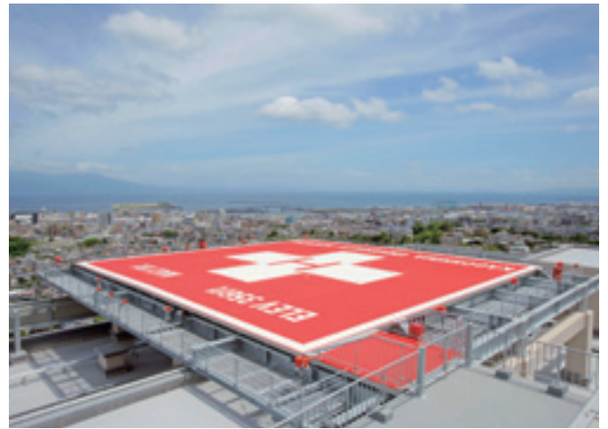
ヘリポート(屋上)
