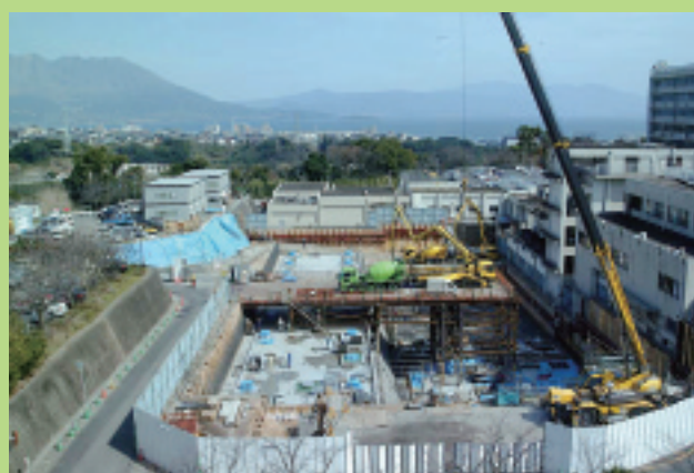
新中央診療棟建築現場 (平成20年3月10日、免震装置取付・免震装置基礎工事)
